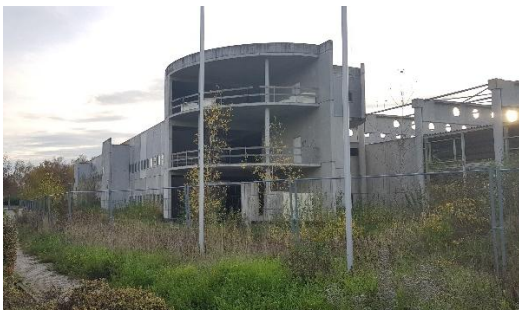
Abbildung 32: Bauruine im Eingangsbereich
