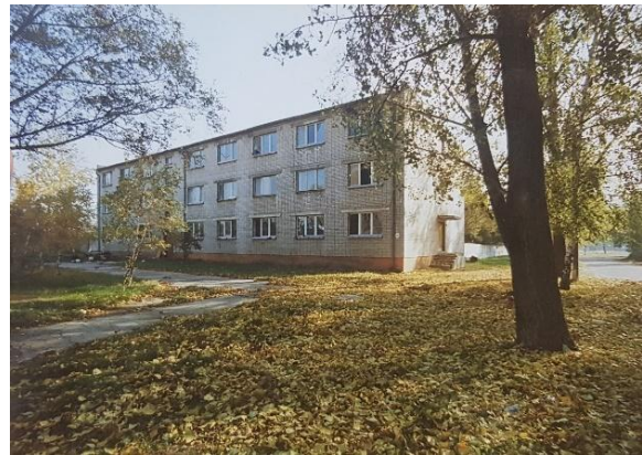
Abbildung 9: TGZ III vor der Sanierung, Foto: Harald Hirsch
