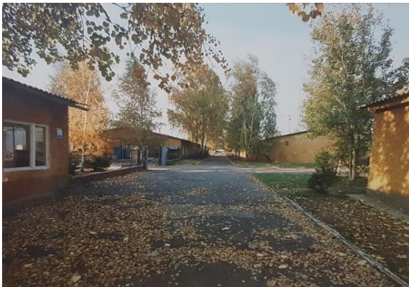
Abbildung 8: Ehemalige Kasernengebäude, Foto: Harald Hirsch
