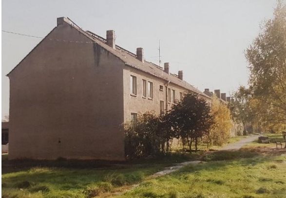
Abbildung 10: Wohngebäude vor der Sanierung, Foto: Harald Hirsch
